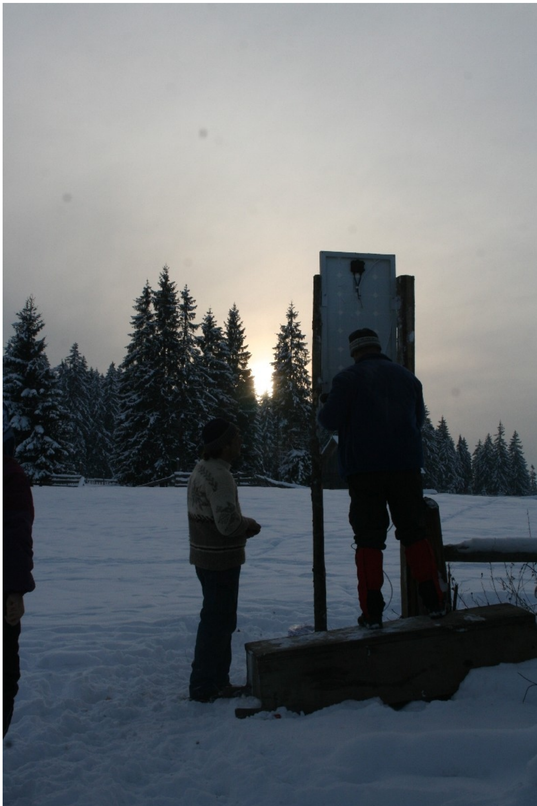
Panoul solar a fost orientat către soare și apoi cablurile au fost aduse în casă unde s-a continuat munca.
